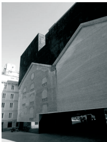
Fot. 3. Madryt – historyczne elewacje wykorzystane w nowoczesnym budynku wystawienniczym, (fot. B. Szmygin).
