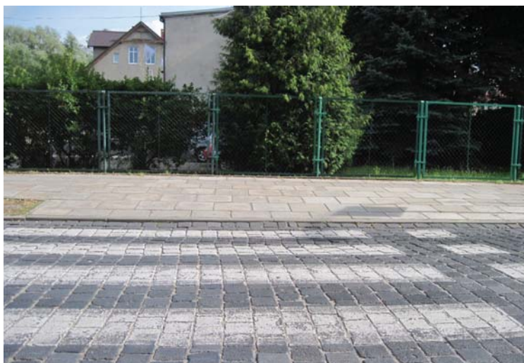
Fot. 5. Przejście dla pieszych z krawężnikami z krawędzią pochyłą – Świnoujście
