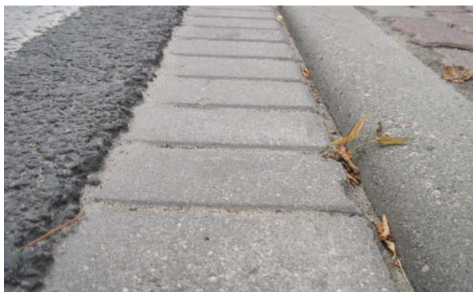
Fot. 4. Przejście dla pieszych z krawężnikiem z krawędzią zaokrągloną – Ciechocinek
