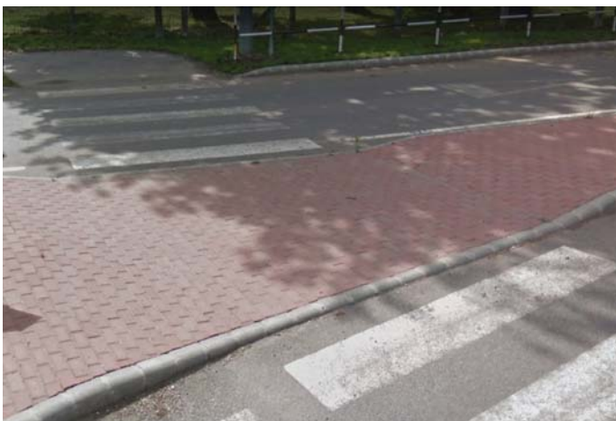
Rys. 8. Przejście dla pieszych z krawężnikiem zaokrąglonym – Hajdúböszörmény (Węgry) – źródło www.google.com/maps
