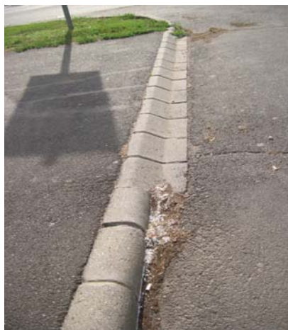
Fot. 9. Przejście dla pieszych z krawężnikiem profilowanym (poza szerokością przejścia widoczny krawężnik zaokrąglony) – Hajdúböszörmény (Węgry)
