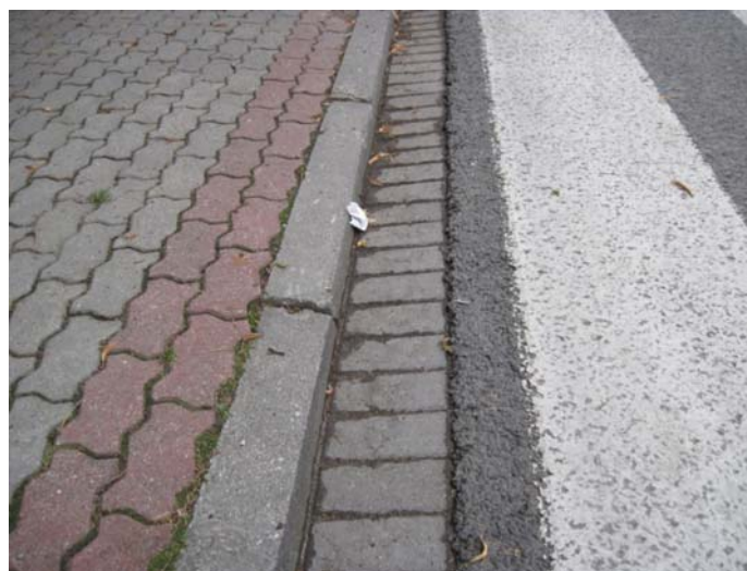
Fot. 3. Przejście dla pieszych z krawężnikiem z ostrą krawężnią – Ciechocinek
