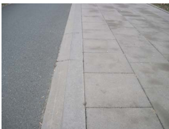
Fot. 10. Krawężnik układany „na płask” pomiędzy drogą dla rowerów a chodnikiem (bez ścieku przykrawężnikowego) nie stanowi problemu w przejeździe wózkami inwalidzkimi – Warszawa
