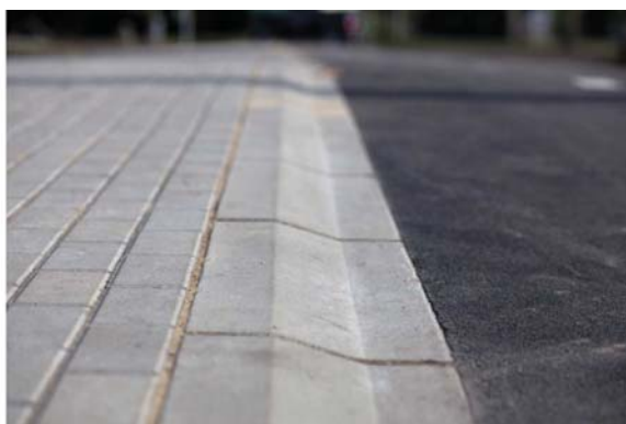
Fot. 11. Krawężnik zatokowy obniżający – rysunek poglądowy (wymiar H:B:L=20/23:30:75cm) i przykład zastosowania (wg [7], fot. ZIEL-BRUK®)
