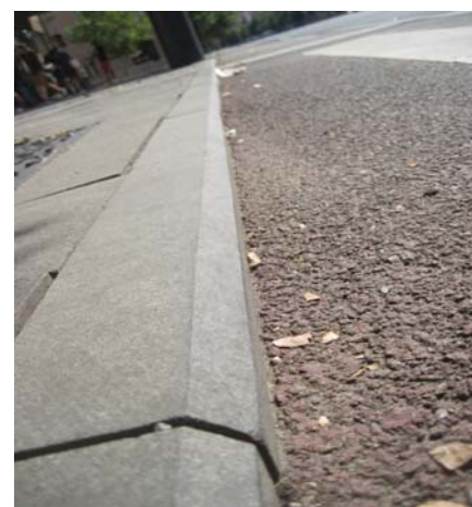
Fot. 6. Przejście dla pieszych z krawężnikiem (obrzeżem chodnikowym) ze ścięciem 2 cm (1:1) – Cluj (Rumunia)
