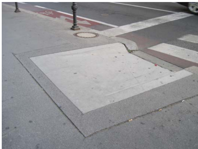
Fot. 1. Przejście dla pieszych z obniżeniem krawężnika tylko na niewielkim fragmencie w formie prefabrykowanej rampy przykrawężnikowej – Lublana (Słowenia)
