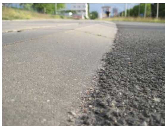
Fot. 10. Krawężnik układany „na płask” pomiędzy drogą dla rowerów a chodnikiem (bez ścieku przykrawężnikowego) nie stanowi problemu w przejeździe wózkami inwalidzkimi – Warszawa
