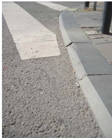
Fot. 7. Przejście dla pieszych z krawężnikiem ze ścięciem 3,5 cm (1:1) – Cluj (Rumunia)
