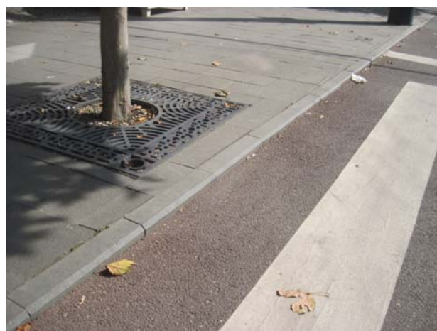
Fot. 6. Przejście dla pieszych z krawężnikiem (obrzeżem chodnikowym) ze ścięciem 2 cm (1:1) – Cluj (Rumunia)
