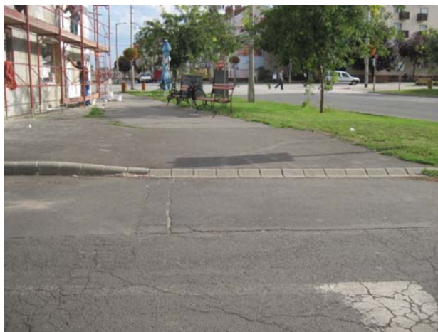
Fot. 9. Przejście dla pieszych z krawężnikiem profilowanym (poza szerokością przejścia widoczny krawężnik zaokrąglony) – Hajdúböszörmény (Węgry)
