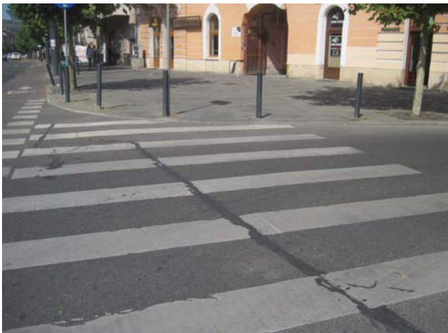
Fot. 7. Przejście dla pieszych z krawężnikiem ze ścięciem 3,5 cm (1:1) – Cluj (Rumunia)
