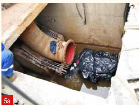
Ryc. 5a) przygotowanie w komorze na wyjście powłoki Phoenix, 5b) widok zamontowanych dysz odprowadzających parę na końcu powłoki Phoenix
