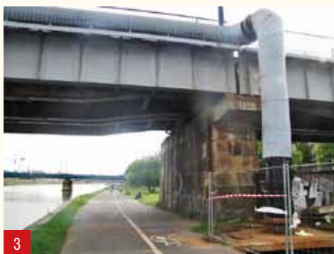
Ryc. 3, 4. Przebieg rurociągu DN 800 oraz montaż rękawa metodą Process Phoenix Double Jacket od strony ul. Podgórskiej w Krakowie, wyjście z komory na most kolejowy, widoczne dwa łuki
