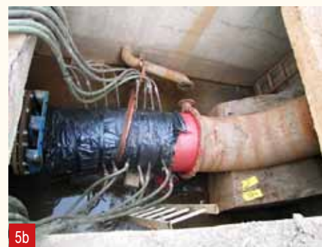
Ryc. 5a) przygotowanie w komorze na wyjście powłoki Phoenix, 5b) widok zamontowanych dysz odprowadzających parę na końcu powłoki Phoenix
