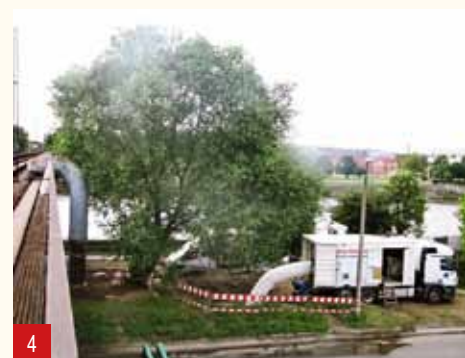
Ryc. 3, 4. Przebieg rurociągu DN 800 oraz montaż rękawa metodą Process Phoenix Double Jacket od strony ul. Podgórskiej w Krakowie, wyjście z komory na most kolejowy, widoczne dwa łuki
