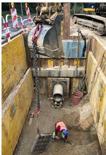
Rys. 20. Zdjęcie z realizacji robót podczas budowy przepompowni PS7 w ul. Sokalskiej
