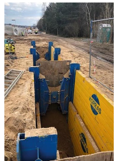
Rys. 14. Zastosowanie liniowej obudowy wykopów OWS 5 AN
