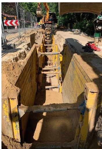
Rys. 17. Zastosowanie obudów skrzynkowych typu STANDARDBOX 3,50x2,40 m z nadstawką 3,50x1,40 m
