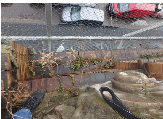
Fot. 9. Widok zabezpieczenia wieżyczki wschodniej
