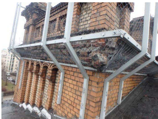
Fot. 7. Widok zabezpieczenia wieżyczki W1
