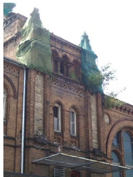
Fot. 6. Przykładowe uszkodzenia oraz widoczna roślin- ność porastająca wieżyczkę W7
