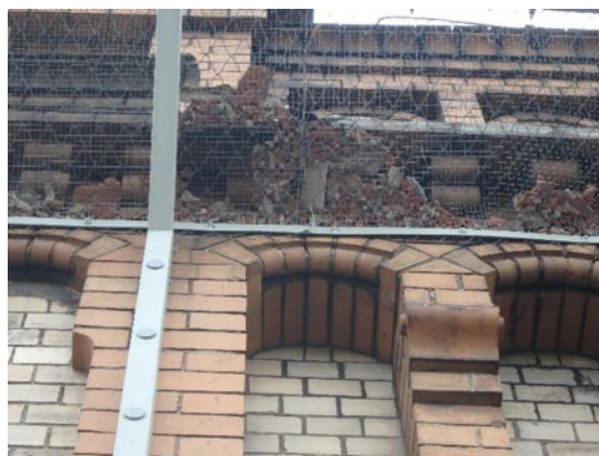
Fot. 8. Widok zabezpieczenia wieżyczki W5
