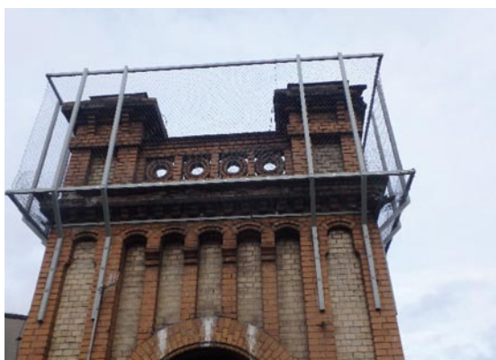
Fot. 11. Widok zabezpieczenia wieżyczki W3
