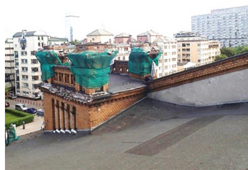
Fot. 2. Wieżyczka W1 – widok z dachu
