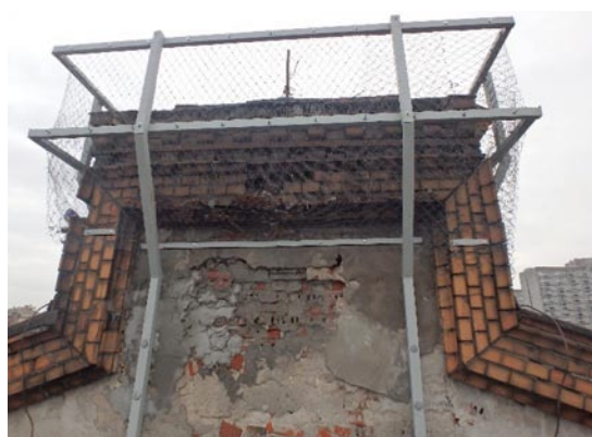
Fot. 10. Widok zabezpieczenia wieżyczki W2
