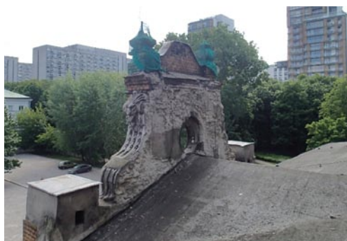
Fot. 6. Przykładowe uszkodzenia oraz widoczna roślin- ność porastająca wieżyczkę W7
