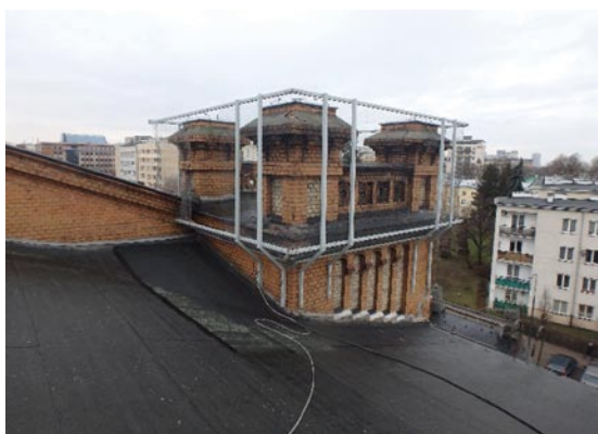
Fot. 13. Widok zabezpieczenia wieżyczki W6
