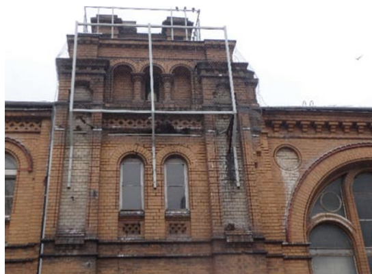
Fot. 14. Widok elewacji północnej
