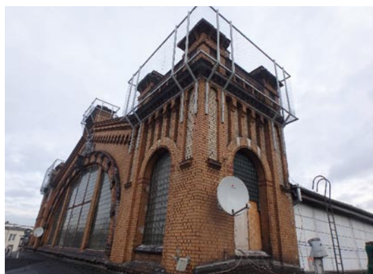
Fot. 12. Widok zabezpieczenia wieżyczki W4
