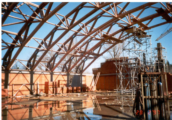
Fig. 1. - tennis hall in Frýdlant nad Ostravicí, 1997, span 40,4 m.
