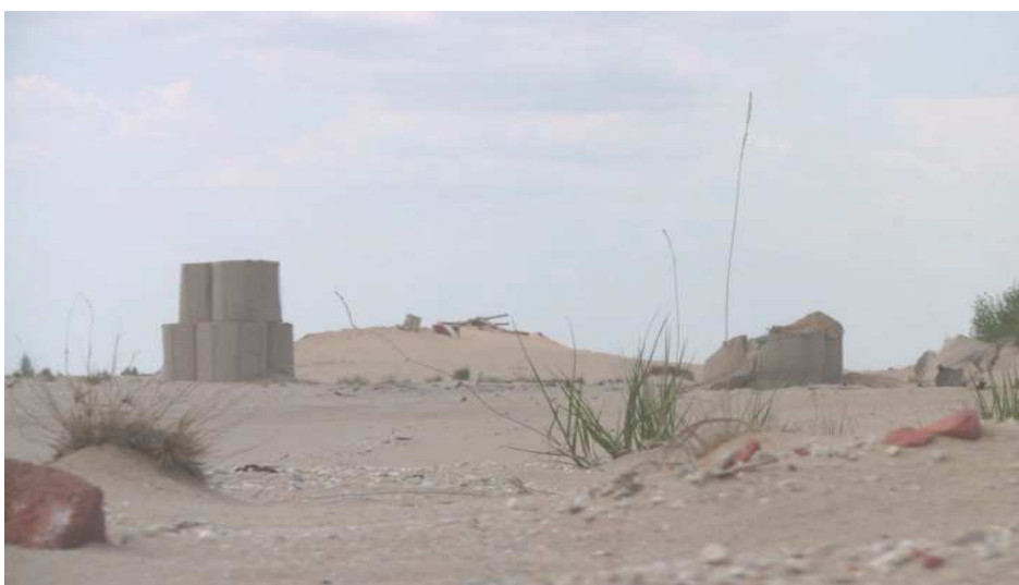
Fot. 4. Fragment umocnienia po trafieniu pierwszym pociskiem.
