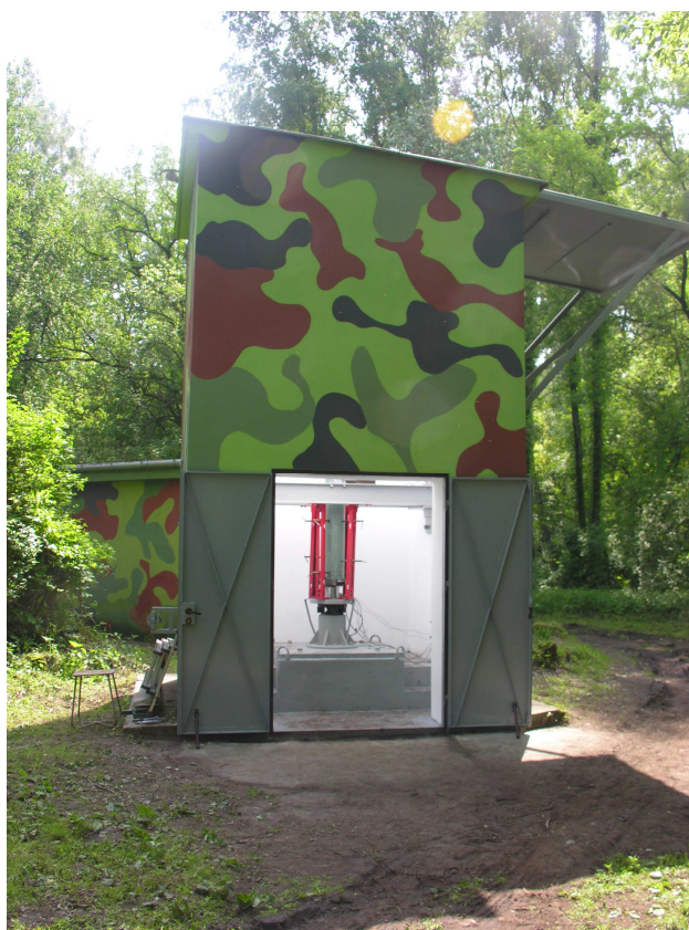
Fot. 8. Widok ogólny hamowni pionowej
