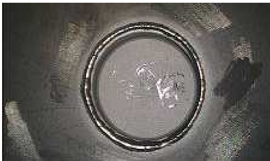
Rys.8. Wnętrze zbiornika, widoczne połączenie spawane korka, przetop pełny, widoczne liczne ślady powierzchniowych zczyszczeń.
