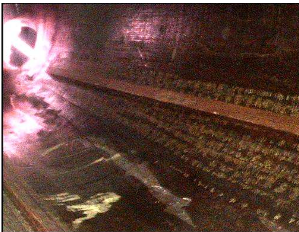
Fot 9 i 10. Wnętrze komory spalania rakiety KUB - powierzchniowe starcia wykładziny termicznej.
