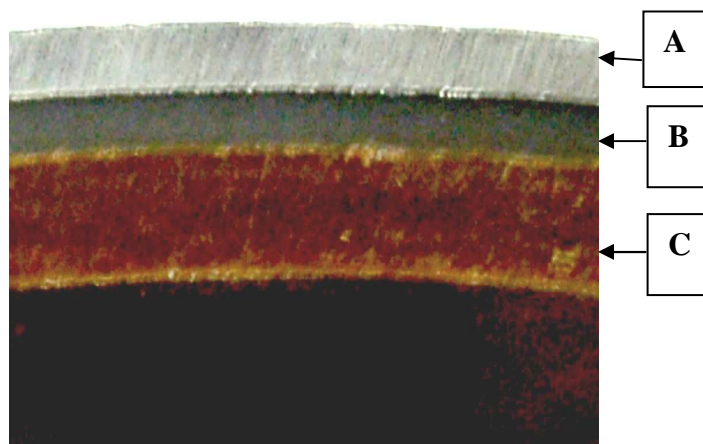
Fot.1. Przekrój poprzeczny przez ściankę komory spalania. Widoczna jest stalowa ścianka (A), warstwa kleju (B) i wykładzina termiczna (C). Powiększenie 7x.
