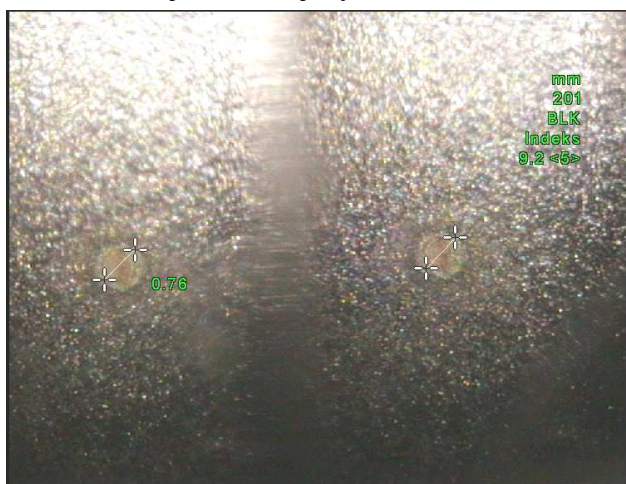
Rys. 4. Pomiar ogniska korozji wewnątrz raketowego zbiornika powietrza na ciśnieniu 275 atm.
