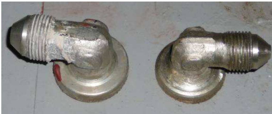
Fot.5. Zmiany korozyjne na króćcu złącza
