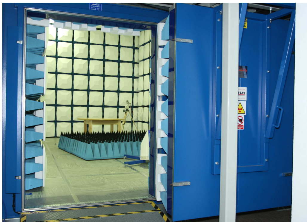
Rys. 1. Wejście do komory
