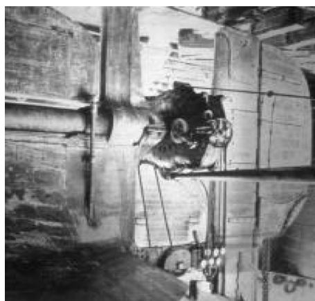
Rys. 4. Hamulec Williama Froude'a zainstalowany na wale okrętu HMS Conquest
