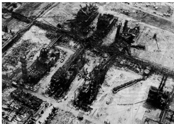
Rys. 1. Fabryka chemiczna (Flixborough, UK), zniszczona w 1974 roku w wyniku wybuchu produkowanego w fabryce cyclohexane z powodu niedostatecznej rozbudowy układu odpowiedzialnego za bezpieczeństwo [1]
