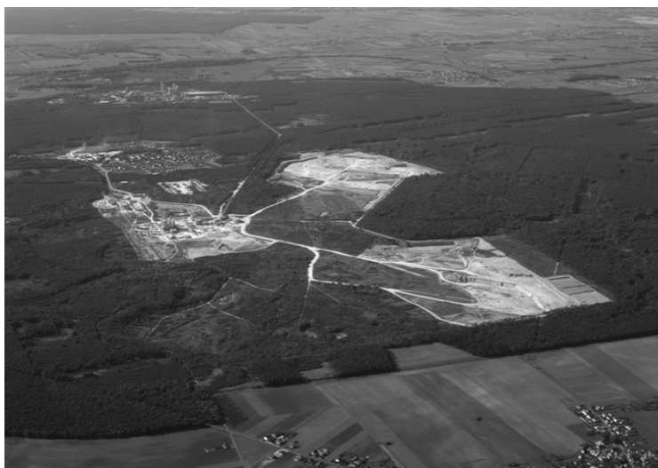
Rys. 2. Wyrobisko zachodnie (nr 1 - u góry) i wschodnie (nr 2 - u dołu) wapieni w Góraźdźach Źródło: Góraźdźce Cement S.A.
