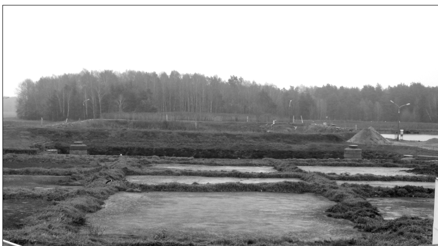
Rys. 4. Widok ogólny na poletka kompostowe, lagunę osadową i laguny trzcinowe w oczyszczalni ścieków w Zambrowie
