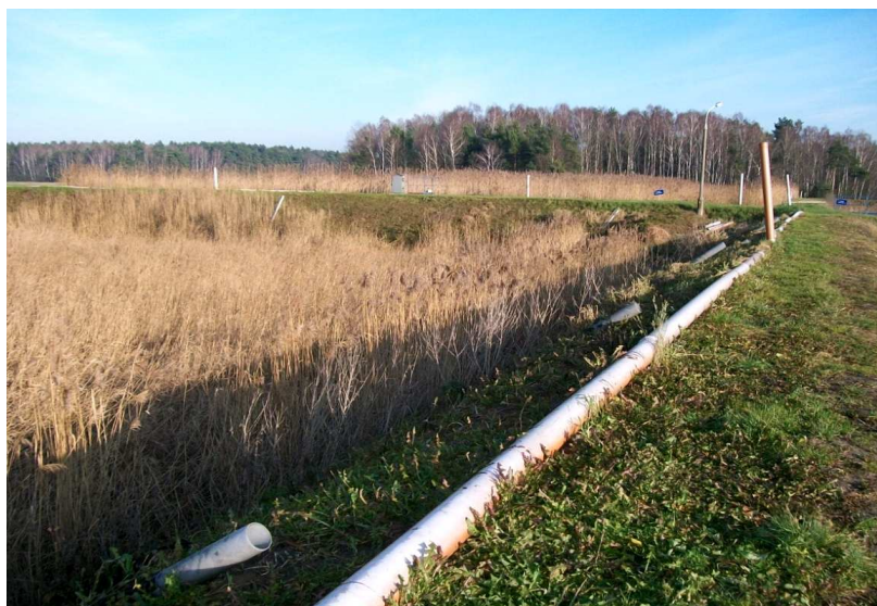
Rys. 2. Laguny trzcinowe w oczyszczalni ścieków w Zambrowie
