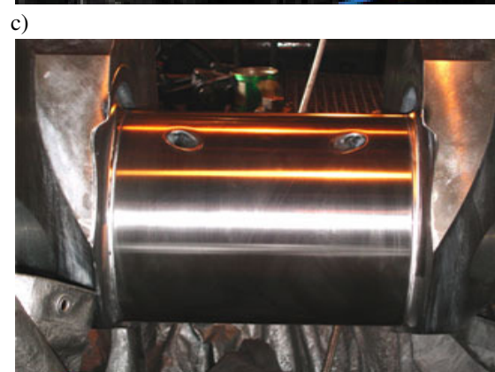
Rys. 3.6. Naprawa czopa korbowego okrętowego silnika spalinowego na silniku: a) w trakcie obróbki, b) widok powierzchni czopa przed naprawą, c) widok powierzchni czopa po naprawie
