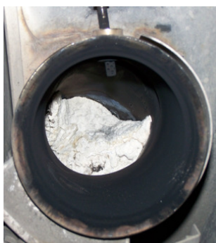
F_1b. Osad na wlocie do reaktora katalitycznego SCR
