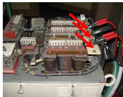
Rys. 6. Regulator napięcia prądnicy z zaznaczonymi miejscami pomiaru napięć międzyfazowych
