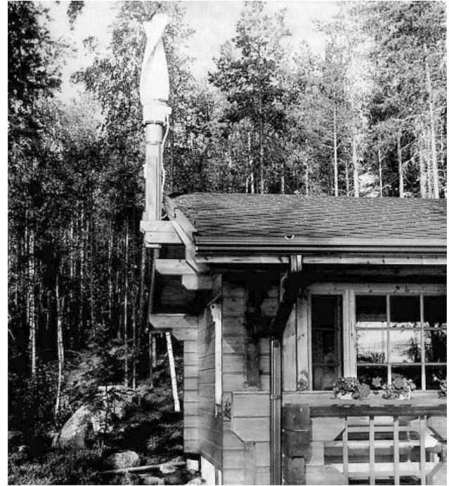
Rys. 5-3. Turbina o osi pionowej typu Winside [5] wkomponowana w zabudowę na terenie chronionego krajobrazu Fig. 5-3. Winside's VAWT [5] mounted on the building in the protected area
