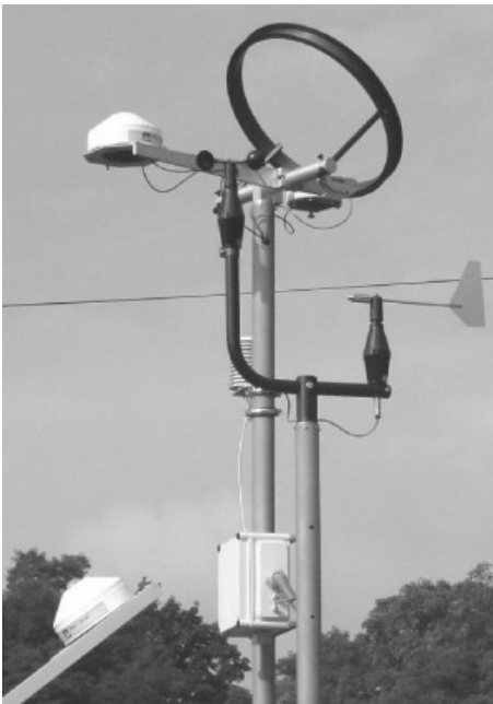
Rys. 2. Stanowisko pomiarowe danych aktywnometrycznych w Laboratorium Fotowoltaicznym SolarLAB we Wrocławiu.
