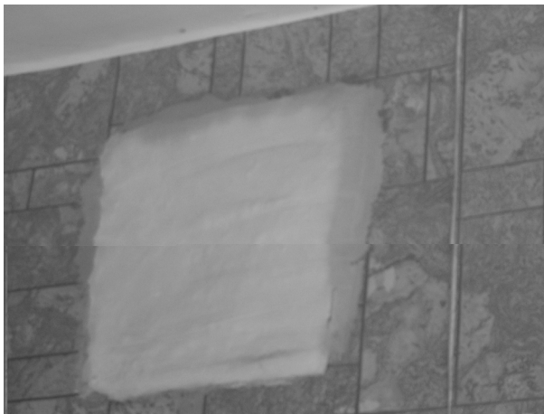
Fot. 2. Skraplanie się pary wodnej na powierzchni zaślepionej kratki wentylacyjnej, opis w tekście.
