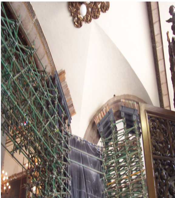
Rys. 6. Doraźne zabezpieczenie sklepień łukowych [25] Fig. 6. Temporary protection of arch vault [25]
