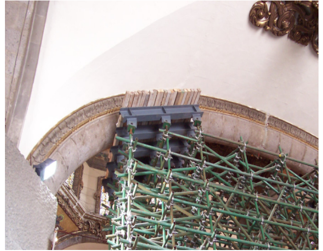
Rys.7. Doraźne zabezpieczenie sklepień łukowych [25] Fig.7. Temporary protection of arch vault [25]
