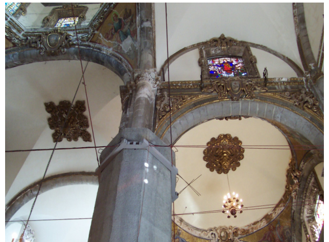
Rys.8. Doraźne zabezpieczenie filarów za pomocą ściągnięć stalowych [25] Fig.8. Steel ties temporary protection of pillars[25]
