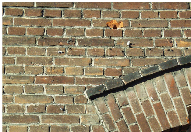
Rys.1. Kolorowa fotografia fragmentu ściany. Fig.1. Colour photograph part of the wall.
