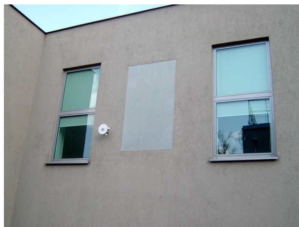
Rys.1 Zespolona izolacja kapilarna Fig. 1 Compound capillary insulation
