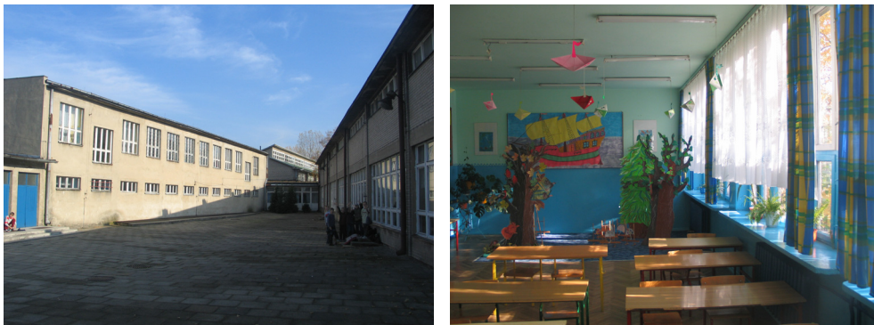
Fot. 1. Szkoła podstawowa nr 1 w Zgierzu wybrana jako obiekt do analiz szczegółowych w projekcie SUREBUILD: dziedziniec wewnętrzny oraz typowa klasa.
