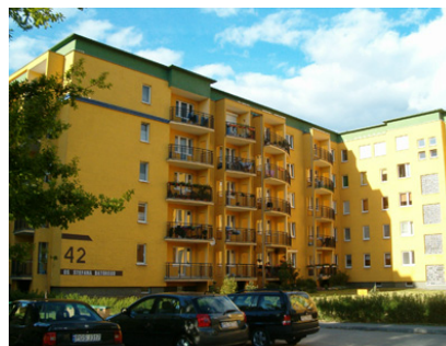
Fot. 1. Widok S – W strony budynku [6].
