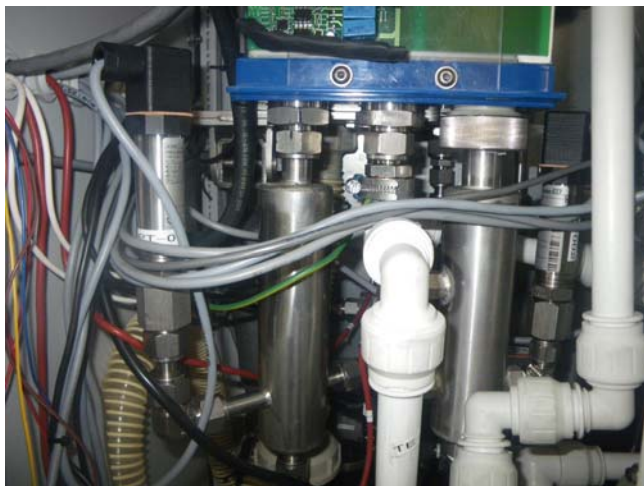
Fot. 1. Realizacja kolektora umożliwiającego recyrkulację wodoru
