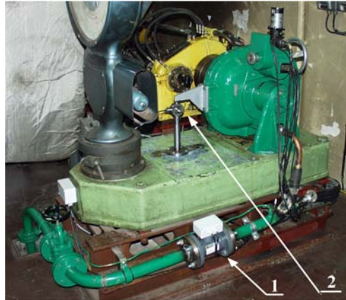
Rys. 8. Widok zamontowanego dynamometru tensometrycznego oraz przepływomierza w instalacji wodnej zasilającej hamulec obciążający:
