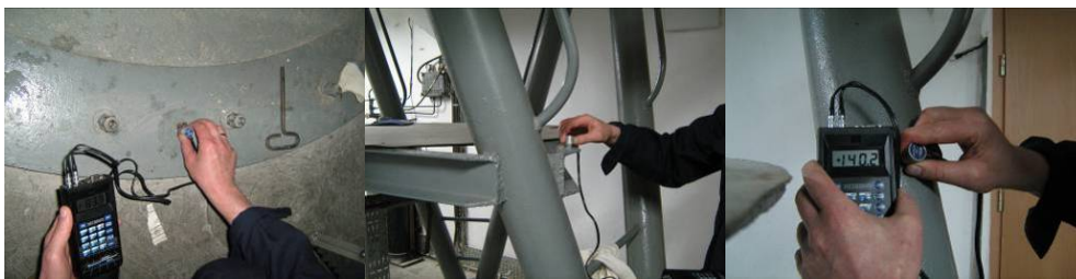
Rys. 8. Pomiary grubości elementów ramy fundamentowej
