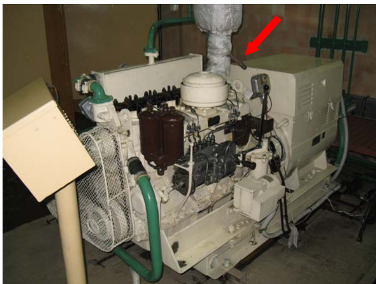
Rys. 1. Widok ogólny morskiego zespołu prądotwórczego ZE400/52 zainstalowanego na stanowisku laboratoryjnym
