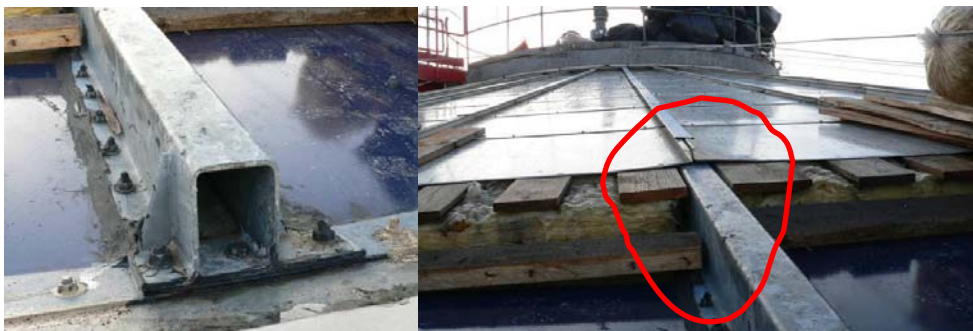
Fot. 5. Wzmocnienie stożkowego dachu i ocieplenie wełną mineralną
