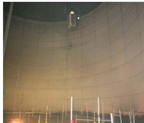
Fot. 2. Poszycie ZKF-u z blach Źródło: zdjęcie wykonane przez autora.
