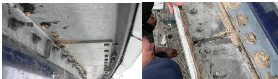
Fot. 4. Łączenie części walcowej i stożkowej ceownikami C 300
