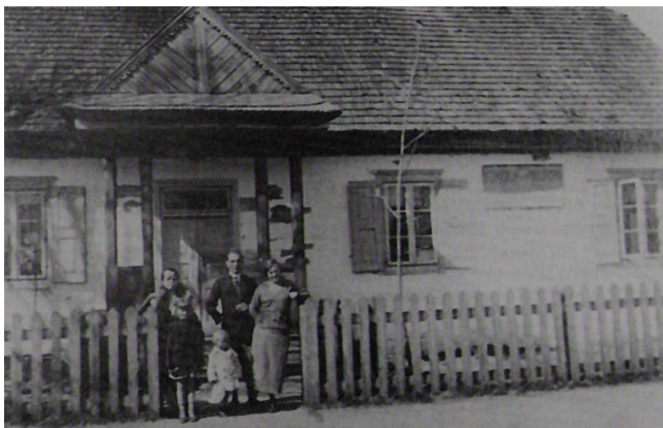
Fot. 1. Budynek szkoły w Mokranach, w którym we wrześniu 1939 r. przetrzymywano jeńców z Floty Rzecznej w Pińsku
