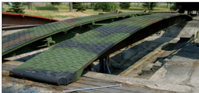
Rys. 3. Widok stanowiska do badań i prób konstrukcji mostowych WZInż. z rozłożonym do położenia przeprowowego mostem BLG
