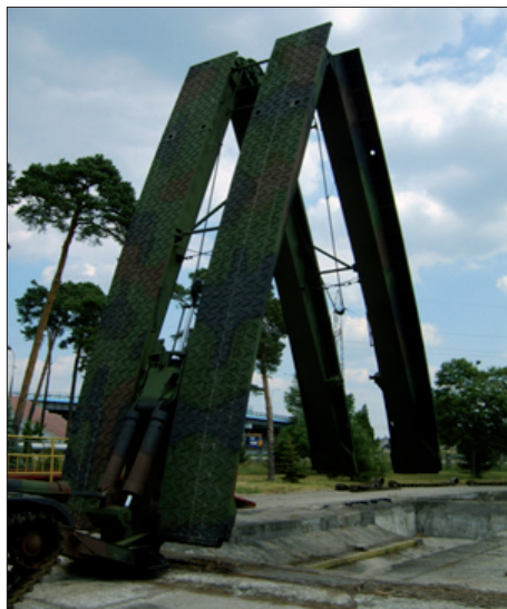
Rys. 2. Widok badanego mostu BLG podczas rozkładania na stanowisku badawczym
