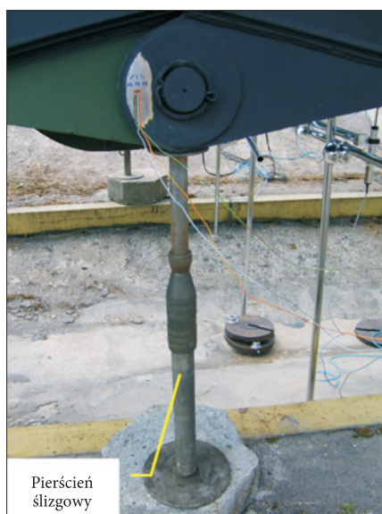
Rys. 5. Widok wyjaśniający położenie czujników mechanicznych do pomiaru przemieszczeń na dźwigarze lewym i prawym mostu
