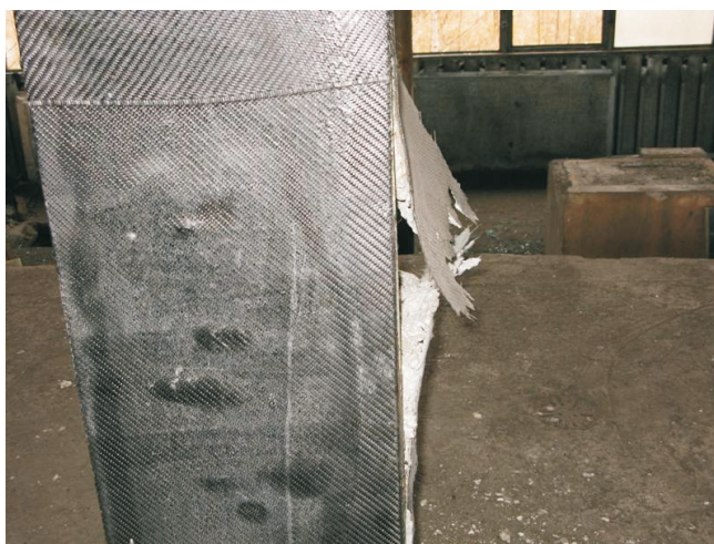
Rys. 40. Słup S4 po wybuchu — widok od strony lewej
