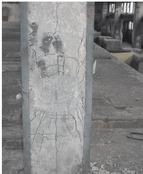
Rys. 29. Słup S1 po wybuchu od strony przyłożenia ładunku
