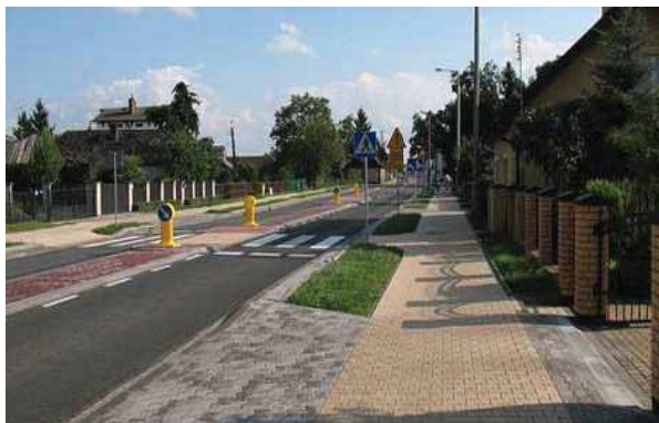
Fot. 1. Przykład wyniesionego przejścia dla pieszych w Puławach.
