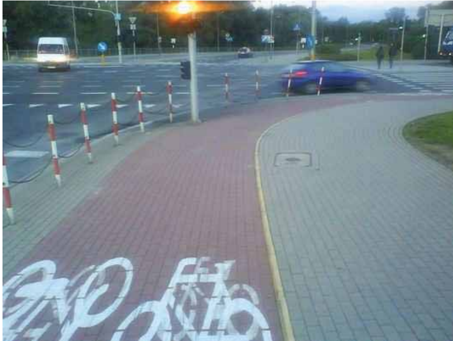
Fot. 11. Niebezpiecznie zaprojektowane skrzyżowanie
