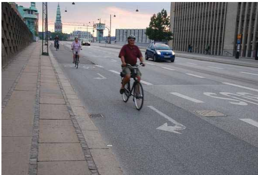
Fot. 10. Bezpieczne połączenie pasa do skrętu w prawo ze ścieżką rowerową
