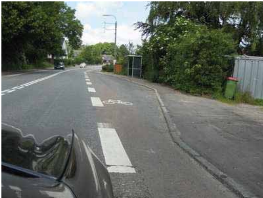
Fot. 5. Ścieżka rowerowa poprowadzona bez kolizji z przystankiem autobusowy
