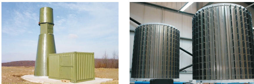
Rys. 5. Radiolatarnia naziemna (rysunek po lewej — wygląd zewnętrzny, rysunek po prawej — wygląd anteny)
