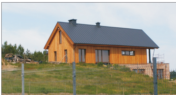
Fot. 1. Zdjęcie analizowanego budynku
