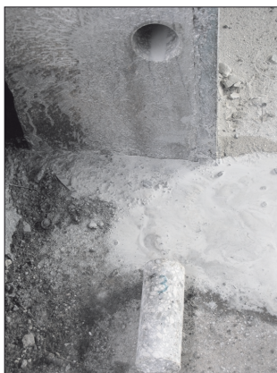
Rys. 17. Otwór w słupie po wykonanym odwiercie
