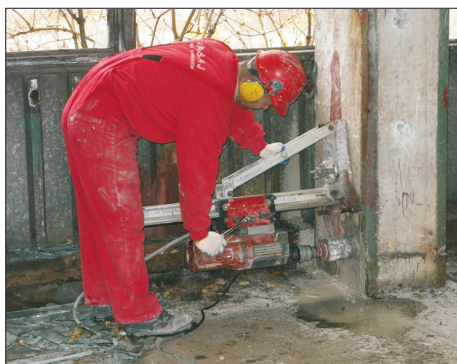
Rys. 16. Wykonywanie odwiertów w słupach
