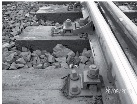
Rys. 4. Przemieszczenia poprzeczne półzwrotnicy; zauważalne większe obciążenie opornicy (jaśniejsza powierzchnia toczna)
