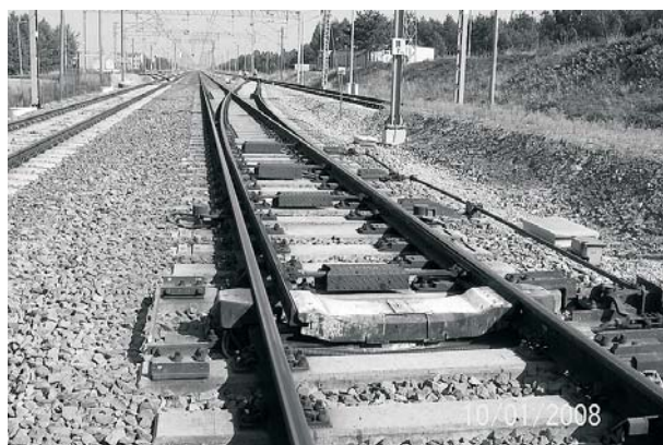
Rys. 1. Rozjazd UIC60-1200-1:18,5 na podrozjazdnicach betonowych na jednej ze stacji Centralnej Magistrali Kolejowej przeznaczony do prędkości 250 km/h po torze zasadniczym i 100 km/h po torze zwrotnym
