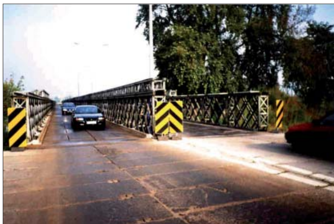
Fot. 2. Most objazdowy z konstrukcji DMS-65 (układ podstawowy trzydziźwigarowy na wspólnych podporach z rur stalowych), dźwigary środkowe wzmocnione — rz. Wisła, m. Fordon k. Bydgoszczy w 2001 r.
