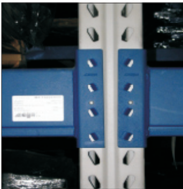
Rys. 2. Fotografia węzła konstrukcyjnego (a) oraz typowy przebieg próby zginania fragmentu trawersu (b)
