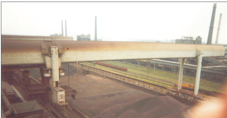
Rys. 1. Powłokowa suwnica przeładunkowa pracująca na składowisku rudy żelaza (widok od strony zachodniej)
