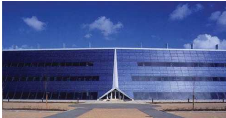
Rys. 17. Międzynarodowy Park Biznesu, Doxford (Wielka Brytania) zasilany panelami fotowoltaicznymi o mocy szczytowej 73 kW [16]
