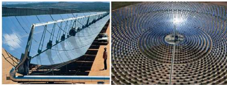
Rys. 13. Widok koncentratora parabolicznego rynnowego (na lewo) skupiającego promieniowanie słoneczne na wieży elektrowni GEMASOLAR o mocy 19,9 MW (na prawo) [11]
