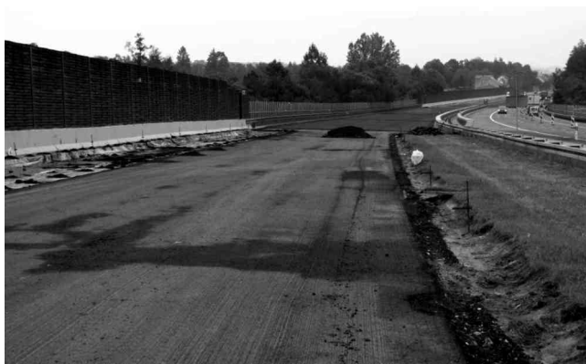
Rys. 5. Odcinek autostrady A4 po frezowaniu [źródło własne]
