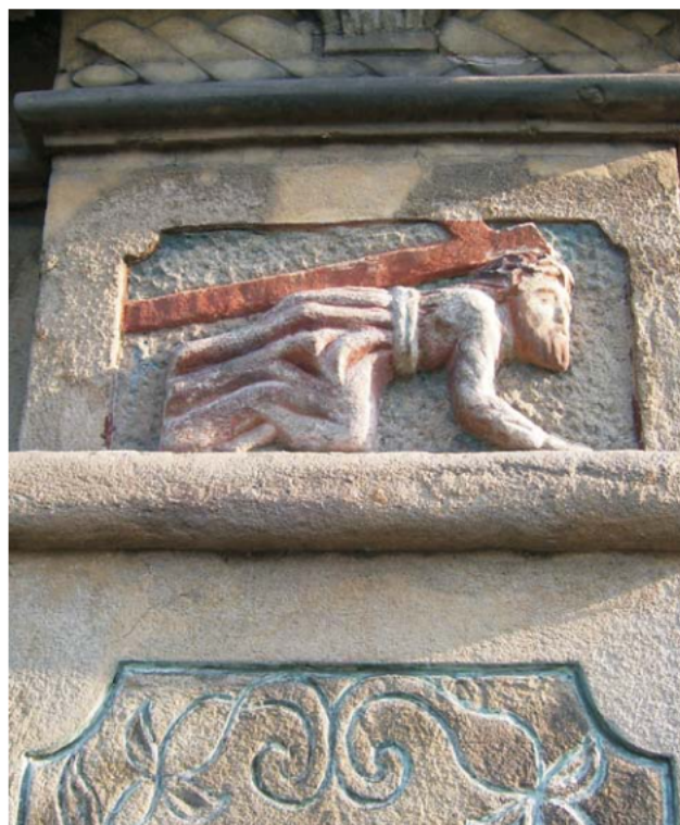
Ryc. 6. Fragment Figury św. Floriana, z 1871 r. (skrzyżowanie ulic Korepty i Ks. Popieluszki), nieznanej fundacji. Obserwowany wzrost szorstkości powierzchni kamienia spowodowany erozyjnym oddziaływaniem opadów atmosferycznych
