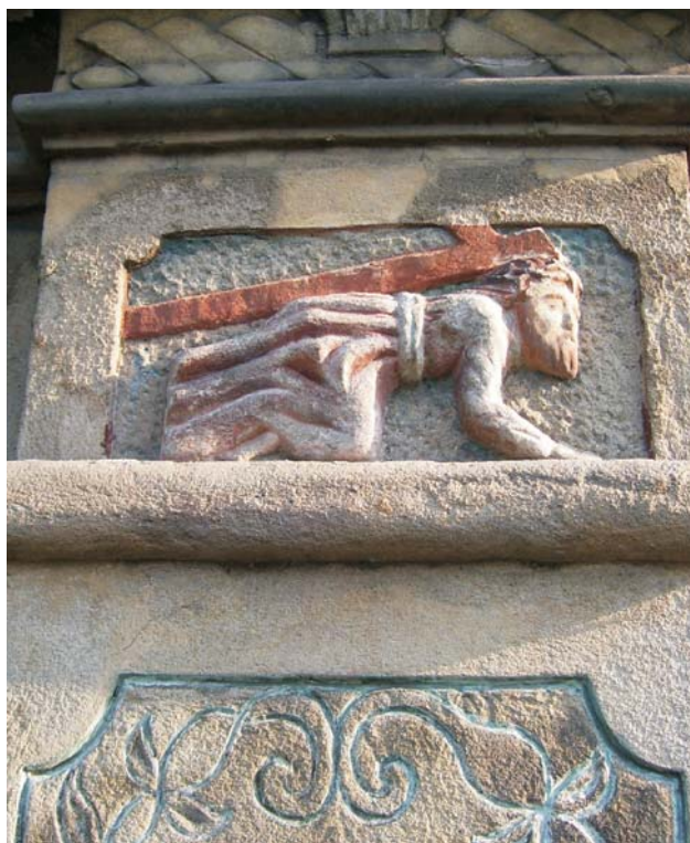
Ryc. 6. Fragment Figury św. Floriana, z 1871 r. (skrzyżowanie ulic Korepty i Ks. Popiełuszki), nieznanego fundacji. Obserwowany wzrost szorstkości powierzchni kamienia spowodowany erozyjnym oddziaływaniem opadów atmosferycznych
