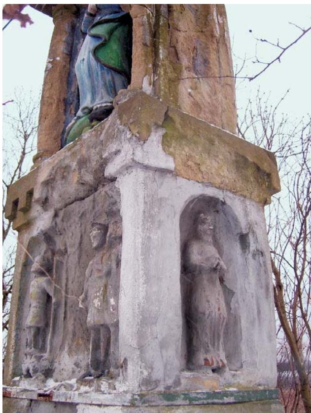
Ryc. 9. Fragment Figury Matki Boskiej, z 1860 r. (skrzyżowanie ulic Babińskiego i Czerwone Maki), fundacji Michała i Katarzyny Derasów; obecność licznych ubytków powodujących zatarcie pierwotnych kształtów figur
