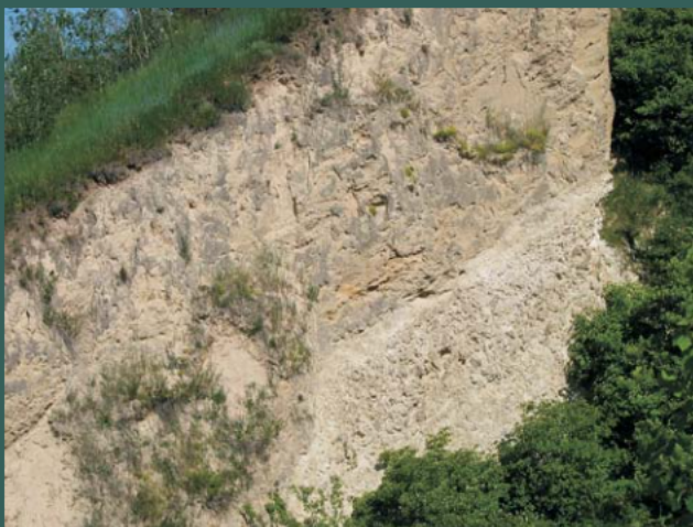
Ryc. 8. Odslonięcie w zboczu wąwozu, skarpa w Dobrem (less stokowy przykrywający rumosz opok) Fig. 8. Exposure in the side of gully, escarpment in Dobrem (slope loess covering opoka debris)
